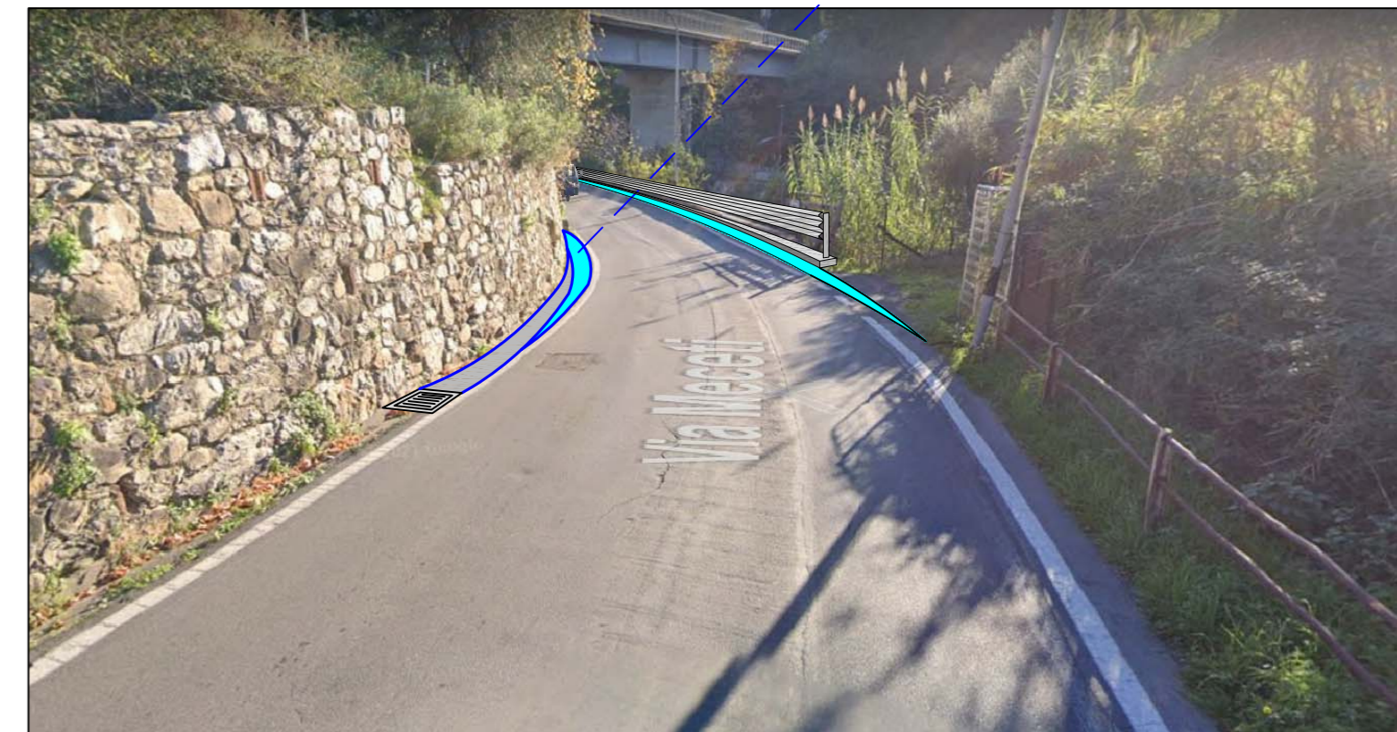
Allargamento carreggiata sulla cunetta esistente
