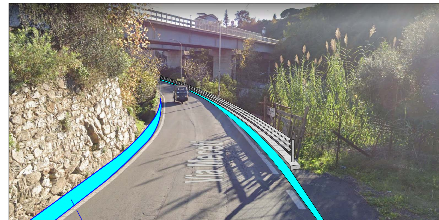
✓ Allargamento carreggiata sulla cunetta esistente
