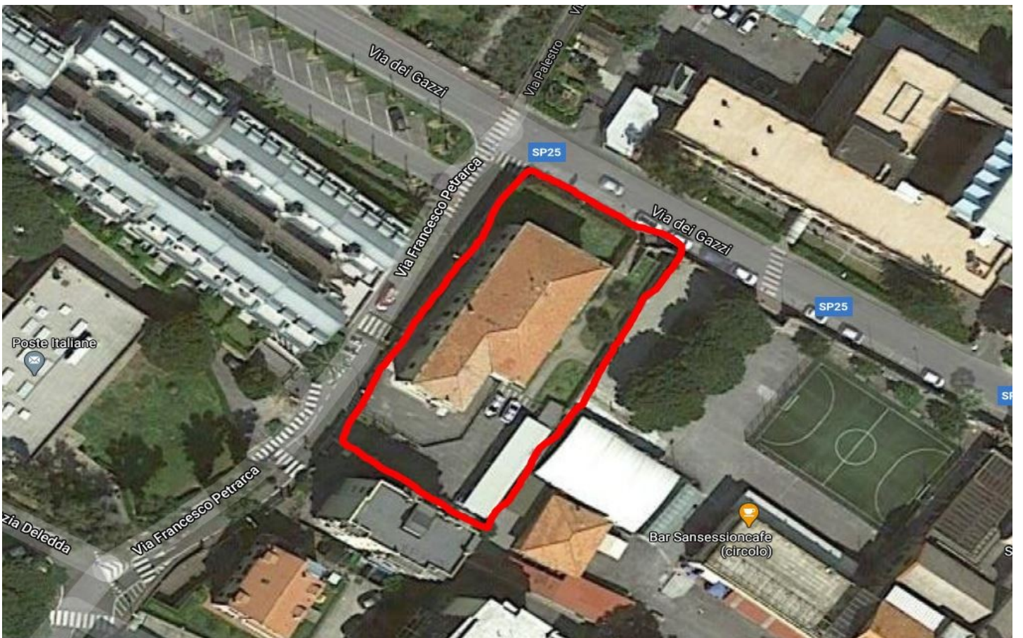
AREA 77 – VIA DEI GAZZI (COMANDO POLIZIA LOCALE)
