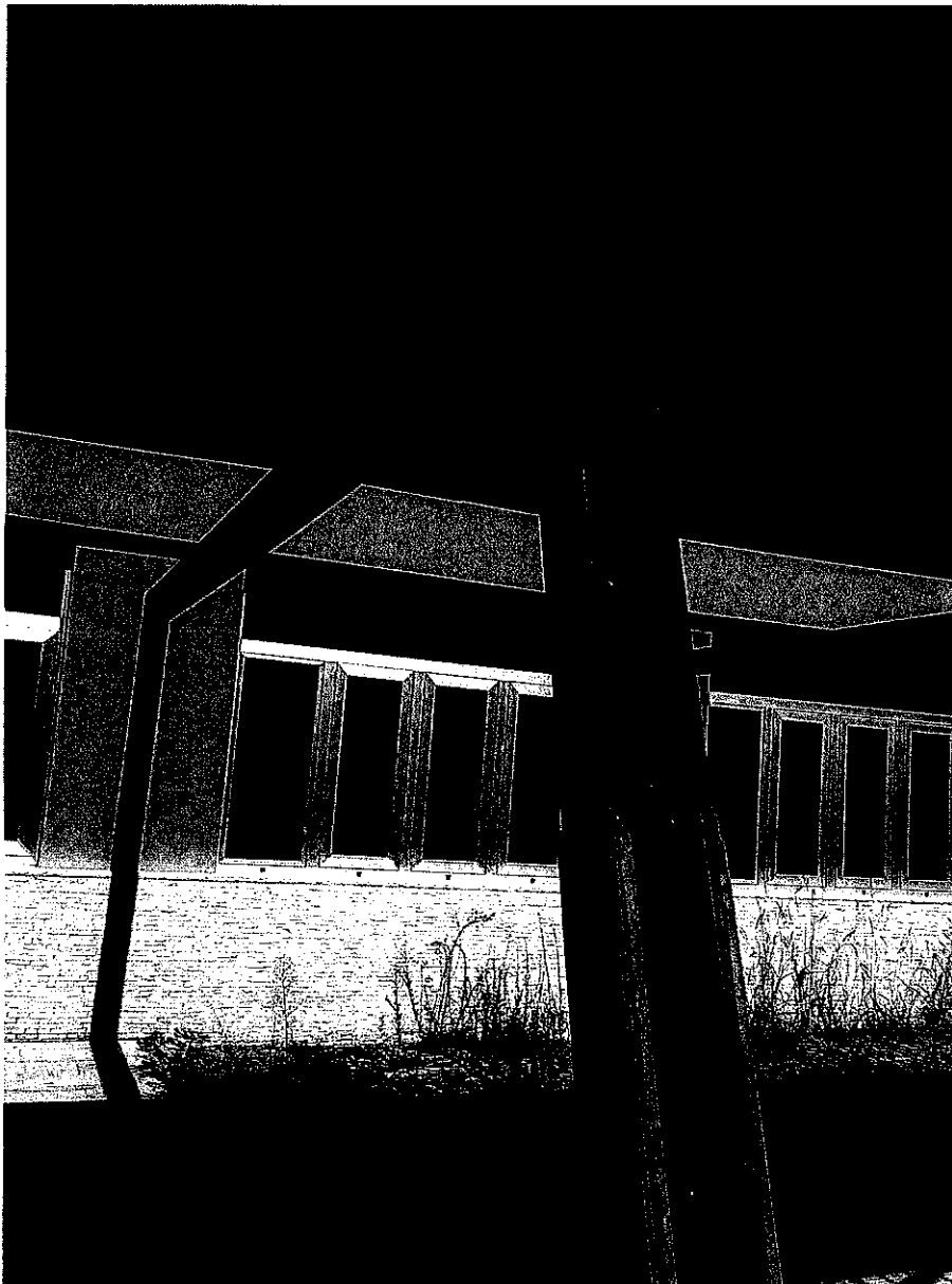
FOTO N.7 Particolare della struttura metallica di sostegno
